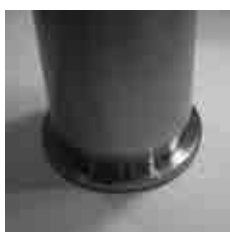
Détail vérin, réglage maxi + 15 mm
